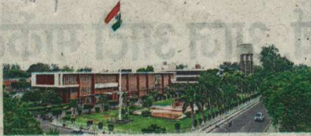
एचएयू का प्रशासनिक खंड-प्लेचर भवन। • पीआरओ
